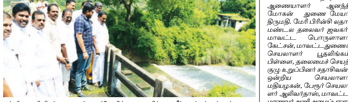
கன்னியாகுமரி கிழக்கு மாவட்டம், நாகர்கோவில் மாநகராட்சிக்கு குடிநீர் வழங்கும் முக்கூடல் அணை தான்கு ஆண்டுக்கு பிறகு முழு கொள்ளளவை எட்டியது. கன்னியாகுமரி கிழக்கு மாவட்டச் செயலாளர் - நாகர்கோவில் மாநகராட்சி மேயர் ரெ.மகேஷ் பார்வையிட்டார்.
