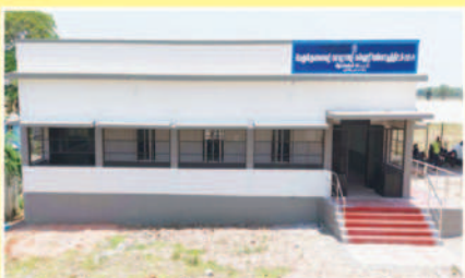
க.தேர் மாவட்டம் கட்டிடக்கலைக்கல்வியியல் கட்டிடம் கட்டுப்பணி. அரசு பாலாலை தொழில்நுட்பக் கல்லூரியில் கட்டிடக்கலை ஆய்வகம் மற்றும் கிணற்று கட்டிடம். மதிப்பீடு ரூ.31.00 இலட்சம்
