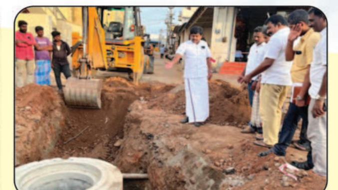
விடுபட்ட பகுதிகளுக்கு முதற்கட்டமாக ரூ.19.019 கோடி மதிப்பீட்டில் பாதாள சாக்கடைத் திட்டப் பணிகள் துவங்கப்பட்டுள்ளது.
