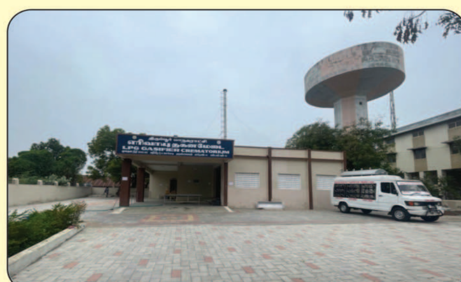
திருப்பூர் மாநகராட்சியின் முருகம்பாளையம் பகுதியில் ரூ.1.50 கோடி மதிப்பீட்டில் எரிவாயு தகன மேடை கட்டி முடிக்கப்பட்டு பொதுமக்கள் பயன்பாட்டிற்கு கொண்டுவரப்பட்டுள்ளது. மேலும், வாவிபாளையம் பகுதியில் ஒரு எரிவாயு தகன மேடை அமைக்கும் பணிகள் முடிக்கப்பட்டு பொதுமக்கள் பயன்பாட்டிற்கு கொண்டுவரப்பட்டுள்ளது.
