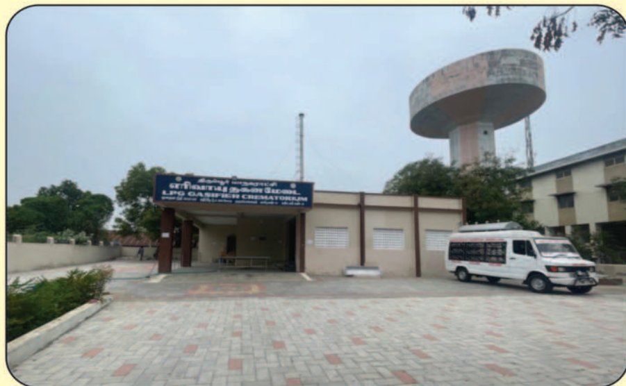
திருப்பூர் மாநகராட்சியின் முருகம்பாளையம் பகுதியில் ரூ.1.50 கோடி மதிப்பீட்டில் எரிவாயு தகன மேடை கட்டி முடிக்கப்பட்டு பொதுமக்கள் பயன்பாட்டிற்கு கொண்டுவரப்பட்டுள்ளது. மேலும், வானிபாளையம் பகுதியில் ஒரு எரிவாயு தகன மேடை அமைக்கும் பணிகள் முடிக்கப்பட்டு பொதுமக்கள் பயன்பாட்டிற்கு கொண்டு வரப்பட்டுள்ளது.
