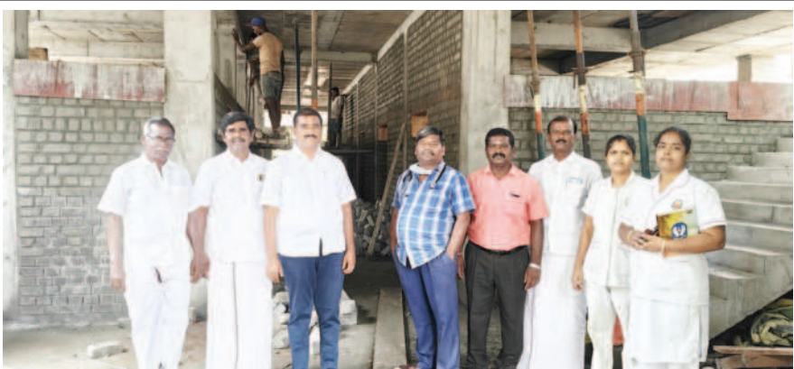
விளாத்திகுளம் அரசு மருத்துவமனையில் ரூ.5 கோடி மதிப்பீட்டில் கட்டப்பட்டு வரும் கூடுதல் கட்டிடங்கள் கட்டுமான இறுதி கட்டப்பணியினை விளாத்திகுளம் சட்டமன்ற உறுப்பினர் ஜி.வி. மாரக்கண்டையன் பார்வையிட்டு ஆய்வு செய்தார். நிகழ்வில் மருத்துவ அலுவலர் கஜேஷ் விளாத்திகுளம் மத்திய ஒன்றிய செயலாளர் ராமசுப்பு, விளாத்திகுளம் தெற்கு ஒன்றிய செயலாளர் இம்மானுவேல், விளாத்திகுளம் பேரூர் கழக செயலாளர் வேலுச்சாமி மாவட்ட பிரதிநிதி ராமலிங்கம் உட்பட செவிலியர்கள் உடன் இருந்தனர்.
