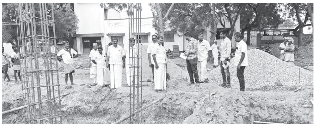
தூத்துக்குடி மாவட்டம் புதூர் ஊராட்சி ஒன்றியம், வெம்பூர் அரசு மேல்நிலைப்பள்ளியில் 49,48 லட்சம் மதிப்பீட்டில் கட்டப்பட்டு வரும் இரண்டு பகுதிகளை கட்டிட பணிபிணை விளைத்திடும் சட்டமன்ற உறுப்பினர், ஜி.வி. மார்த்தண்டியன் பார்வையிட்டு ஆய்வு செய்தார். நிகழ்வில் புதூர் வட்டார வளர்ச்சி அலுவலர் தினகரன், ஒன்றிய செயலாளர் முல்லைத்தி, ராஜா ஆறுமுகம், செல்வராஜ், இம்மாதுகேள்வி, ஒன்றிய அமைத்தலைவர் பொன்னாடி, மாவட்ட நெசவாளர் அணி துணை அமைப்பாளர் லட்சுமணன் மாவட்ட மாணவரணி துணை அமைப்பாளர் ஆகாஷ் பாண்டியன் உடன் கலந்து கொண்டனர்.
