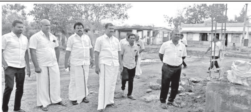
துரத்துக்குடி மாவட்டம் ஒட்டப்பிடாரம் ஊராட்சி ஒன்றியம், சில்லாங்குளம் மற்றும் மேலமங்கலம் உள்ளிட்ட ஊர்களில் கட்டப்பட்டு வரும் சமுதாய நலக்கூட கட்டிடங்களின் கட்டுமானப் பணிபிணை விளாத்திகுளம் சட்டமன்ற உறுப்பினர், ஜி.வி. மாரக்கண்டையன் பார்வையிட்டு ஆய்வு மேற்கொண்டார். உடன் ஒன்றிய செயலாளர்கள் காசிவிஸ்வநாதன், இம்மானுவேல், மாவட்ட பிரதிநிதி சத்யராஜ், உள்ளிட்ட கழக நிர்வாகிகள் உடன் இருந்தனர்.
