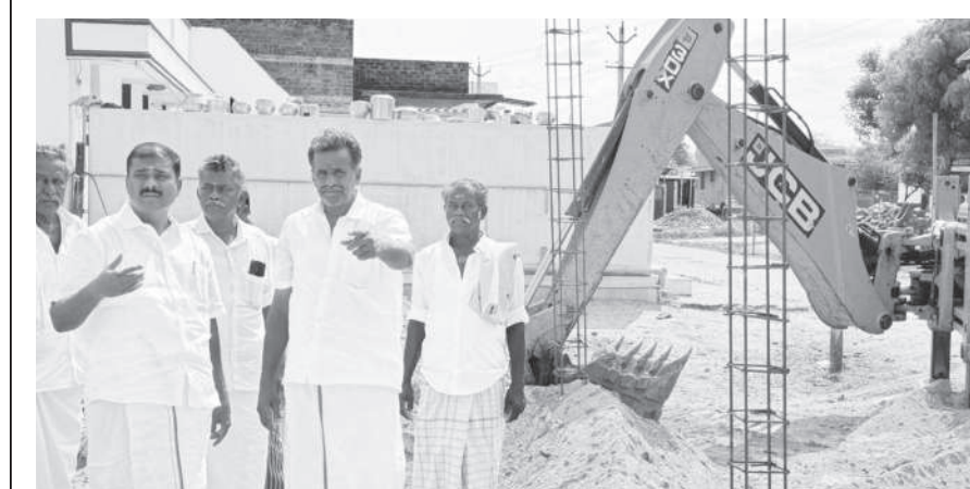
விளாத்திகுளம் ஊராட்சி ஒன்றியம், ஆற்றங்கரை ஊராட்சி, கல்குமி கிராமத்தில் ரூ.53லட்சம் மதிப்பீட்டில் கட்டப்பட்டு வரும் சமுதாய நலக்கூட கட்டுமான பணியினை விளாத்திகுளம் சட்டமன்ற உறுப்பினர் ஜி.வி. மாணிக்கமேயன் பார்வையிட்டு அரசு அலுவலகங்களிடும், ஒப்பந்தகாரரிடும் உரிய அறிவுரை வழங்கினார். உடல் ஆற்றங்கரை முன்னாள் ஊராட்சி மன்ற தலைவர் சீதாராமன் வடக்கு மாவட்ட கலை இலக்கிய அணி துணை அமைப்பாளர் ஆவுடையப்பன், கழக நிர்வாகி பேச்சியப்பன், ஊர் முன்னாள் தர்மகத்தா சங்கராமி, விளாத்திகுளம் சட்டமன்ற தொகுதி தகவல் தொழில்நுட்ப அணி ஒருங்கிணைப்பாளர் பரிநீர், இளைஞரணி செல்வகுமார் உள்ளிட்டோர் உடன் இருந்தனர்.
