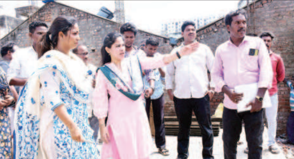
பிக்கின்பால் விளையாட்டுத் திடல் மற்றும் ரூ.60 இலட்சம் மதிப்பீட்டில் கட்டப்பட்டு வரும் மகளிர் உடற்பயிற்சித் திடல் உள்ளிட்ட கட்டுமானப் பணிகளைப் பார்வையிட்டு, பணிகள் அனைத்தும் விரைந்து முடித்து பொதுமக்கள் பயன்பாட்டிற்குக் கொண்டு வர அலுவலர்களுக்கு அறிவுறுத்தினார்.
