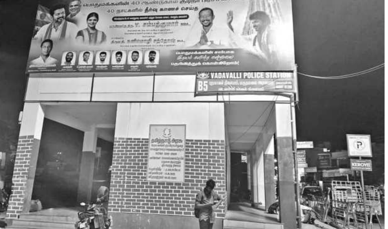
கோவை வடவள்ளி காவல் நிலையத்தின் பெயர் மாலை மறையும் அளவுக்கு ஆளும் கட்சியின் தோல்விகள் வைக்கப்பட்டுள்ளன. கோவையில் தொடர்ந்து நடைபெறும் பல்வேறு சட்டம் - ஒழுங்கு பிரச்சினைகளை கட்டுப்படுத்த முடியாமல் இருக்கும் காவல்துறை தமிழ்நாடு அரசுக்குச் சொந்தமான கட்டிடத்தில் உள்ள காவல்துறை அலுவலகத்தை த.வெ.க. கட்சி அலுவலகம் செயல்பட வாடகைக்கு கொடுத்துவிட்டதா? என்று கோவை மாநகர் மாவட்ட கழக பொறுப்பாளர் துரை.செந்தமிழ்செல்வன் கேள்வி எழுப்பி உள்ளார்.
